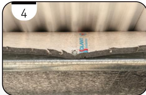
Para disminuir el rasgado de la membrana y poder tensar con más fuerza, se sugiere poner arandela metálica de 5cm de diámetro.
