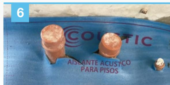
Es muy importante que el perímetro de la habitación también sea cubierto por la membrana con el fin de evitar los puentes acústicos, así también deben aislarse los pases de desagües o tuberías.
