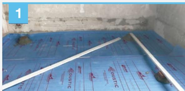
Empezando por un lateral de la habitación, coloque a lo largo de la misma el primer rollo de Contrapiso ACOUSTIC® con el film impreso hacia arriba.
