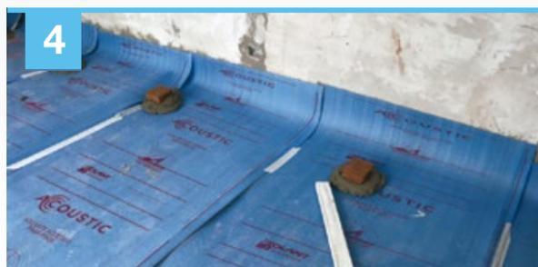
Instale el resto de los rollos, teniendo cuidado de superponer el solape 5 cm para garantizar la continuidad de la capa aislante. Dichos bordes presentan un rebaje para poder termosoldar la unión con pistola de calor.
