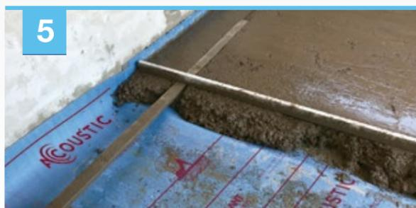
Una vez que se ha enrasado el contrapiso y la carpeta, puede procederse a cortar el excedente de membrana con una trincheta.
