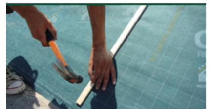
**REGULADOR DE VAPOR:** Covering® es permeable al vapor que se emite desde el interior de la construcción. Si se condensa ese vapor, el agua no ingresa a la misma. Un techo respirable mejora el confort y la salud de su hogar.
