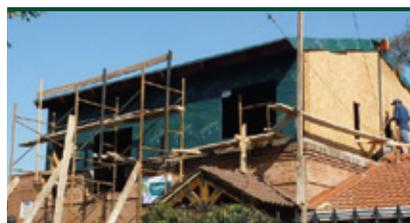
**BARRERA DE VIENTO:** Covering® es una excelente barrera de viento. Por sus características, evita las infiltraciones no deseadas de aire (viento externo y/o convección) y en consecuencia, la ganancia o pérdida de temperatura, ahorrando energía utilizada para calefaccionar y/o refrigerar su casa.
