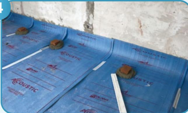
Instale el resto de los rollos, teniendo cuidado de superponer los bordes 5 cm para garantizar la continuidad de la capa aislante. Dichos bordes presentan un rebaje para poder termosoldar la unión con pistola de calor.
