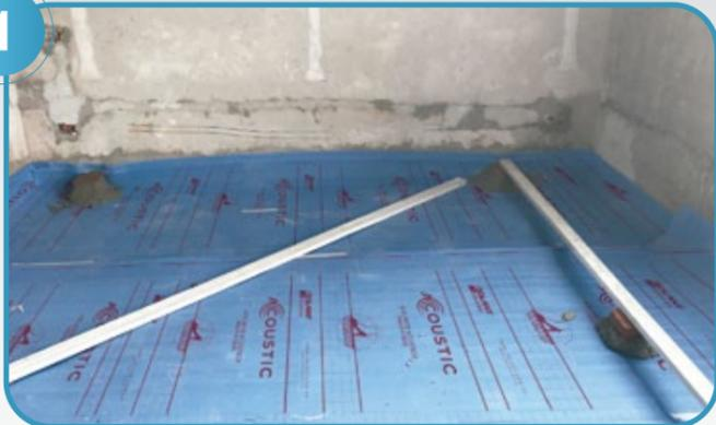
Empezando por un lateral de la habitación, coloque a lo largo de la misma el primer rollo de **Contrapiso ACOUSTIC®** con el film impreso hacia arriba. No es necesario clavar o pegar la membrana a la losa.
