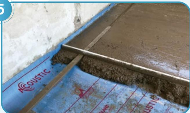
Una vez que se ha enrasado el contrapiso y la carpeta, puede procederse a cortar el excedente de membrana con una trincheta.
