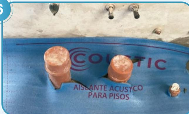
Es muy importante que el perímetro de la habitación también sea cubierto por la membrana con el fin de evitar los puentes acústicos, así también deben aislarse los pases de desagües o tuberías.
